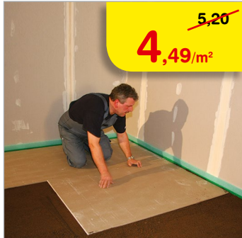
Gipskartonio plokštė sausosioms grindims Knauf Brown Paprastai ir lengvai montuojama. Klojama dviem sluoksniais. Mažas konstrukcijos svoris, gera garso izoliacija. Matmenys: 12,5x900x2000 mm.
